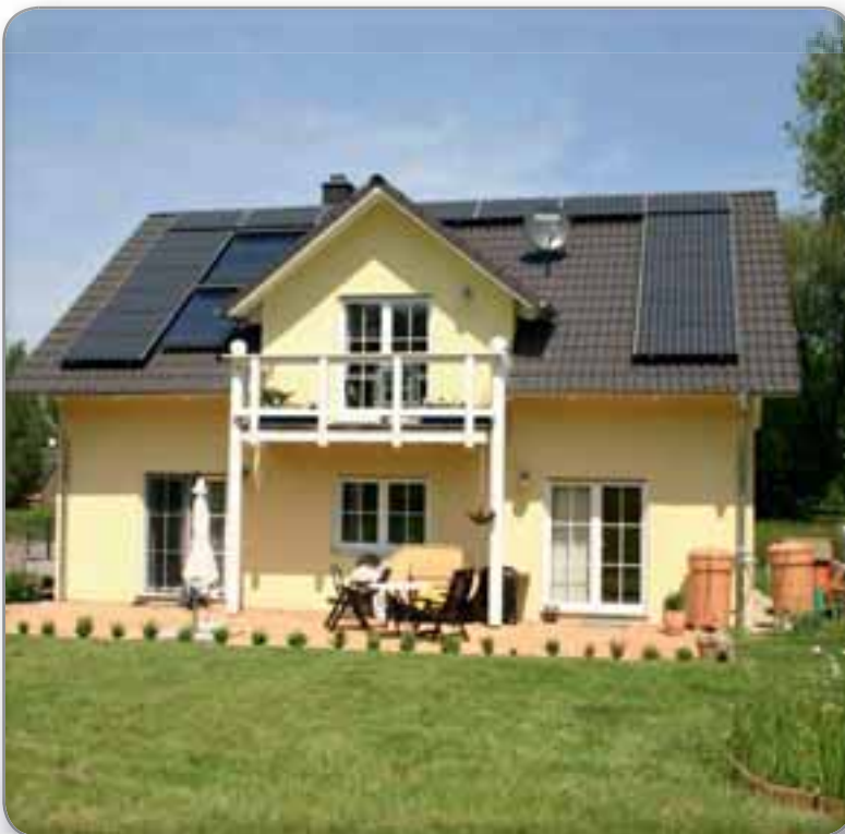
Installateur: Bachstein Solar, Sanyo HIT 210 NKHE 5
